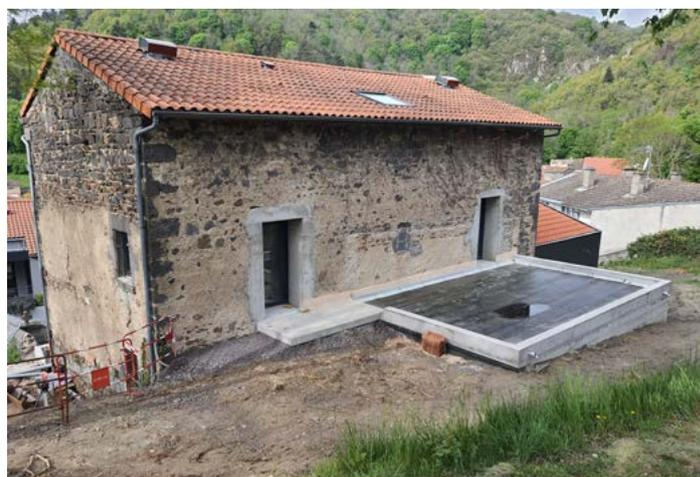
L'aménagement d'un local technique sur la partie arrière du bâtiment ainsi que du remblaiement vont permettre un accès direct à la classe provisoire qui va être ouverte au deuxième étage du bâtiment, en supprimant l'escalier prévu dans le projet initial.
